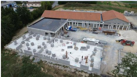
*Les fondations et la dalle de la crèche sont en place, l'élévation des murs a débuté*
